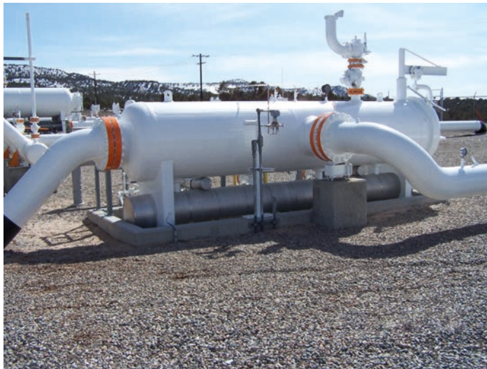
☒ Grundständiger Aufbau eines Filterseparators (Symbolbild).
