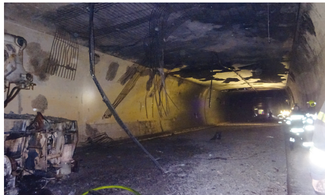
Das Flammeninferno hat große Schäden angerichtet Bildquelle: FF Übelbach-Markt
