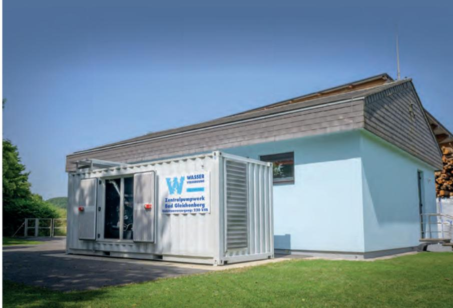
Mobiles Notstromaggregat des „Wasserverband Wasserversorgung Vulkanland“
