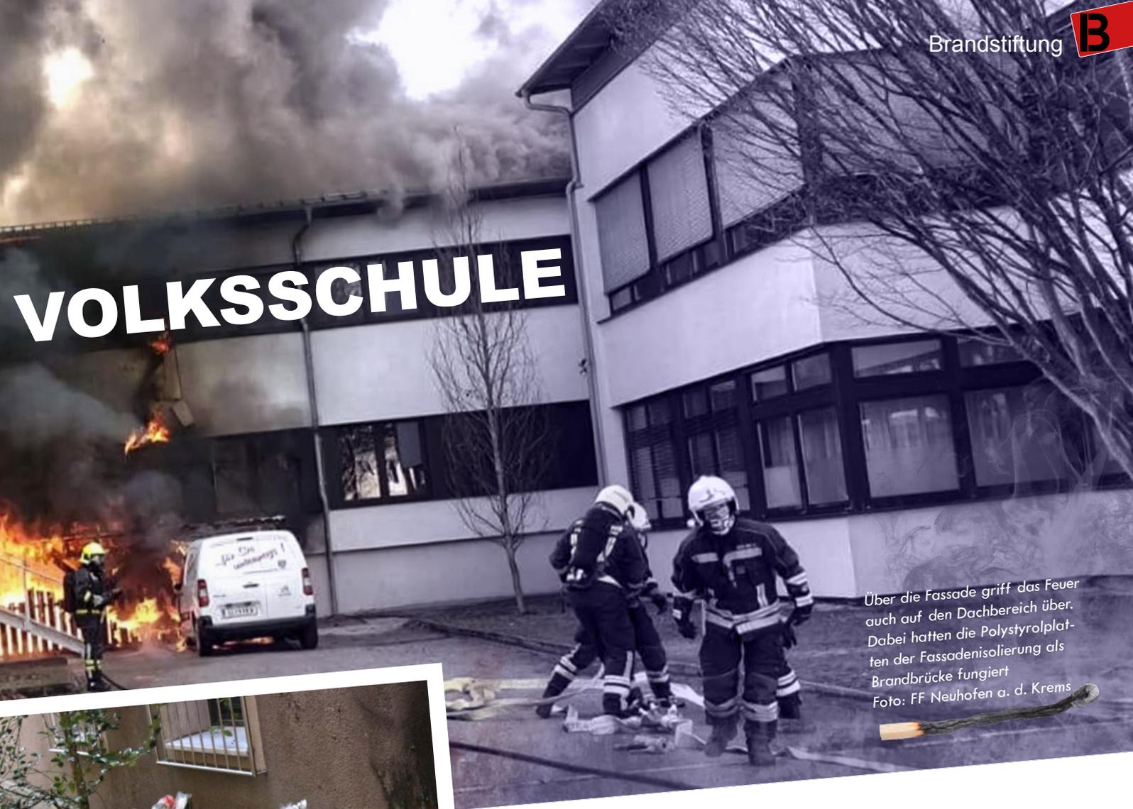
Über die Fassade griff das Feuer auch auf den Dachbereich über. Dabei hatten die Polystyrolplatten der Fassadenisolierung als Brandbrücke fungiert
