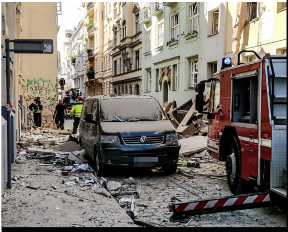
Bild der Zerstörung: Nach der Detonation ist die unmittelbare Umgebung übersät von Glasscherben und von zu Bruch gegangenen Fenstern und Mau- erwerk. Foto: Kevin Hofmann/APA
