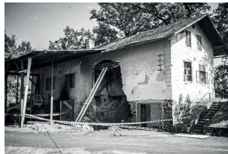
Schwere Bau-schäden nach „Tresor-Explosion“ in Weitendorf im Jahre 1984 (Bild: Owid).
